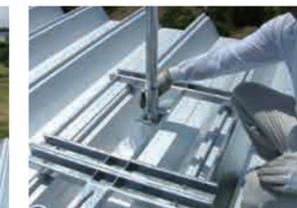
⑥ 支柱ベースソケット部に支柱の穴にトグルピンを貫通させて固定してください。
