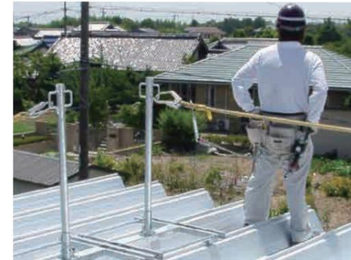
安全帯取付け設備としての性能・強度を持ち、屋根での作業を安全に行えます。屋根面への負荷が少なく、インパクトレンチで簡単に固定出来ます。さらに支柱を単管パイプ・幅木に取付けることで防護工用支柱となります。
