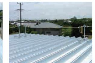
⑧ 親綱を取付け、緊張器を用いて、概ね水平になるように緊張して完成です。
