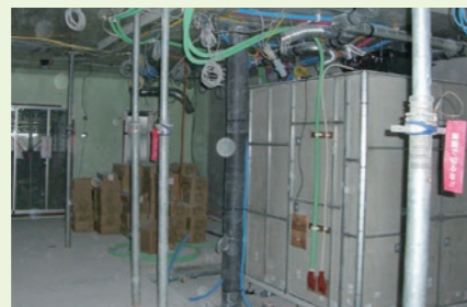
ユニット設置
