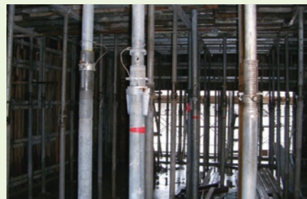
解体前（打設後約2日目）
