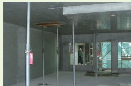
一般支保工解体直後（打設後約4日目）
