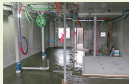
床レベリング工事
